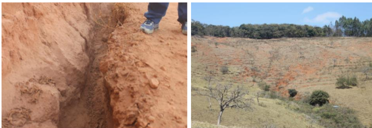
Estradas não pavimentadas
