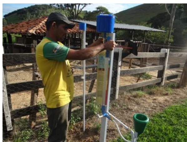
Instalação do Irrigâmetro na propriedade de Leandro Fernandes Ferreira
