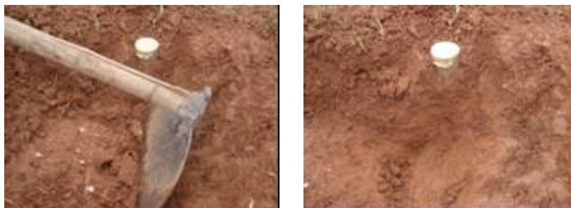
Figura 12. Escavação lateral ao tubo de PVC.
